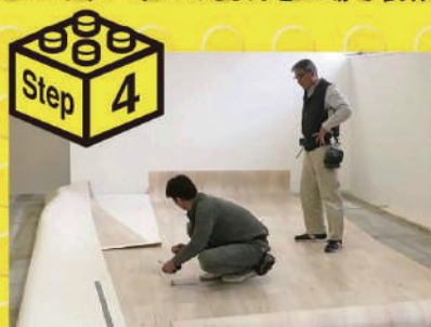
内装・設備工事
