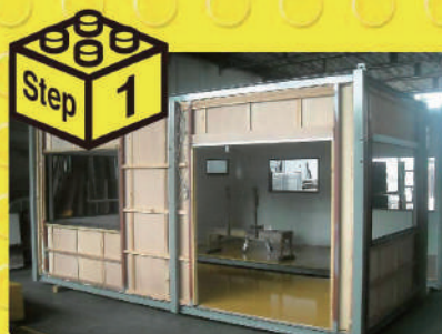
ユニットハウスの90%を工場で作
