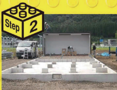
ユニット製作と同時に基礎工事を進行
